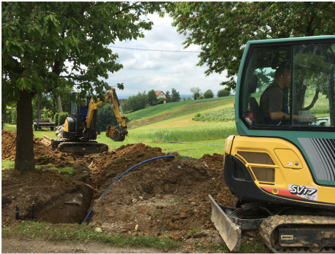
Dela za prevezavo na nov vodovod
