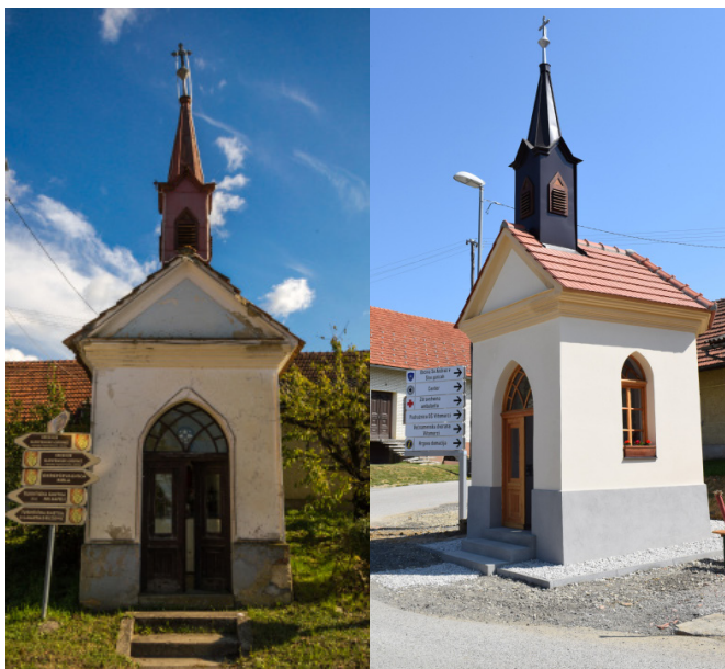
Antonekova kapelica pred in po obnovi
